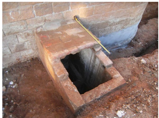
FOTO 12. Estructura UE 112 localitzada al tocar del pavelló de Sant Rafael
