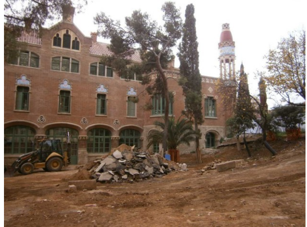
FOTO 2. Situació inicial de la intervenció
