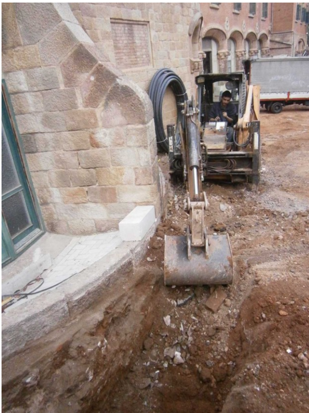
FOTO 3. Inici de les tasques d'excavació
