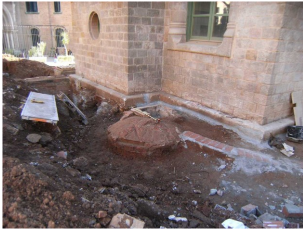
FOTO 13. Estructura UE 110 localitzada a tocar del pavelló de Sant Leopold
