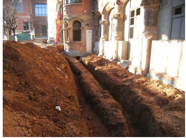
FOTO 6. Estat final de les tasques d'excavació al voltant del pavelló de Sant Rafael
