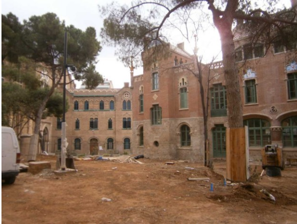
FOTO 1. Situació inicial de la intervenció
