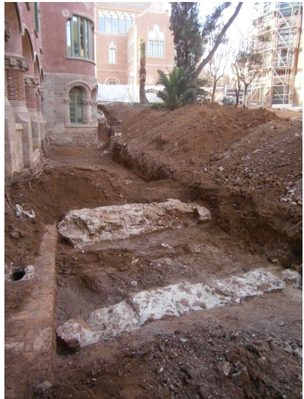
FOTO 8. Estructures UE 145 i 146 en la rasa al voltant del pavelló de Sant Leopold
