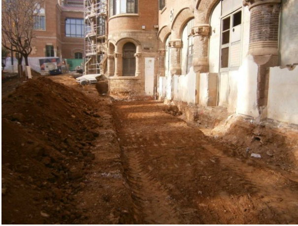
FOTO 5. Tasques d'excavació al voltant del pavelló de Sant Rafael
