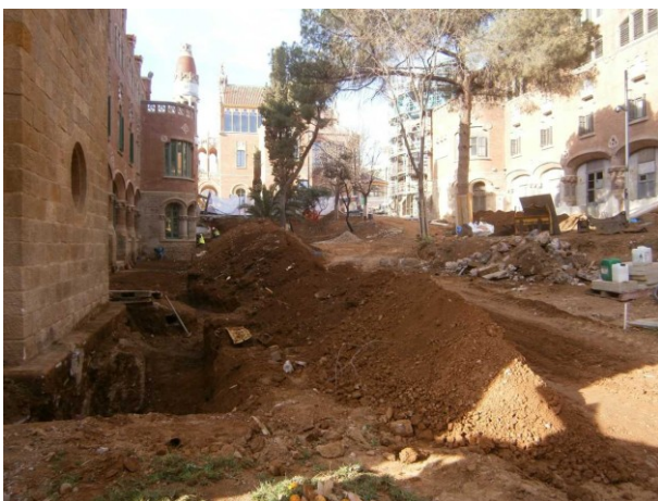
FOTO 7. Estat final de les tasques d'excavació al voltant del pavelló de Sant Leopold
