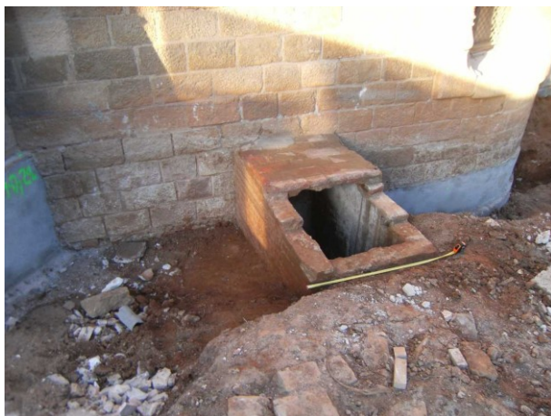
FOTO 11. Estructura UE 112 localitzada al tocar del pavelló de Sant Rafael
