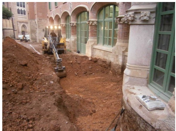
FOTO 4. Tasques d'excavació al voltant del pavelló de Sant Leopold
